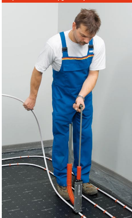
Rys.4. Układanie rury grzewczej
