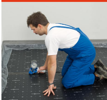
Rys.3. Oklejanie taśmą samoprzylepną krawędzi styku płyt izolacyjnych
