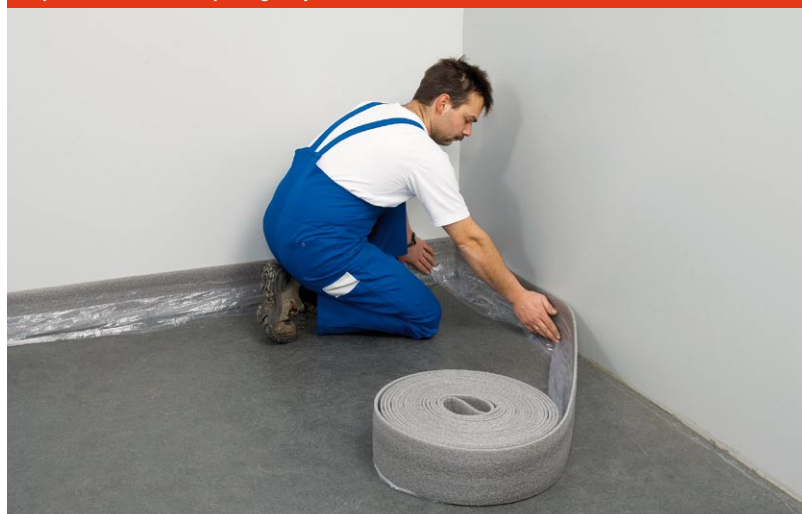
Rys.2. Układanie taśmy brzegowej
