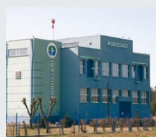
Miejskie Wodociągi i Oczyszczalnia, Grudziądz, Polska
